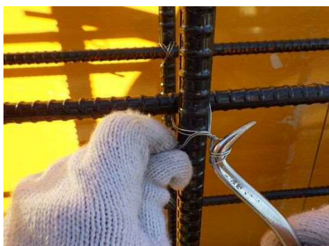
写真-2 鉄筋ハッカーによる鉄筋結束状況
