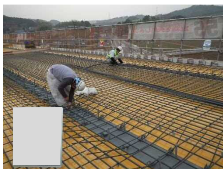
写真-1 手作業による鉄筋結束状況
