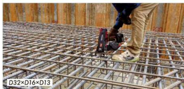
写真-3 リバータイア 1) (鉄筋結束機)
