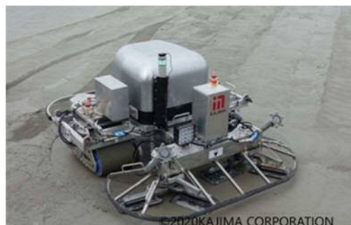
写真 2-7 仕上げロボット NEW コテキング
