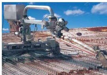
写真 2-8 打設ロボット デービーロボ
